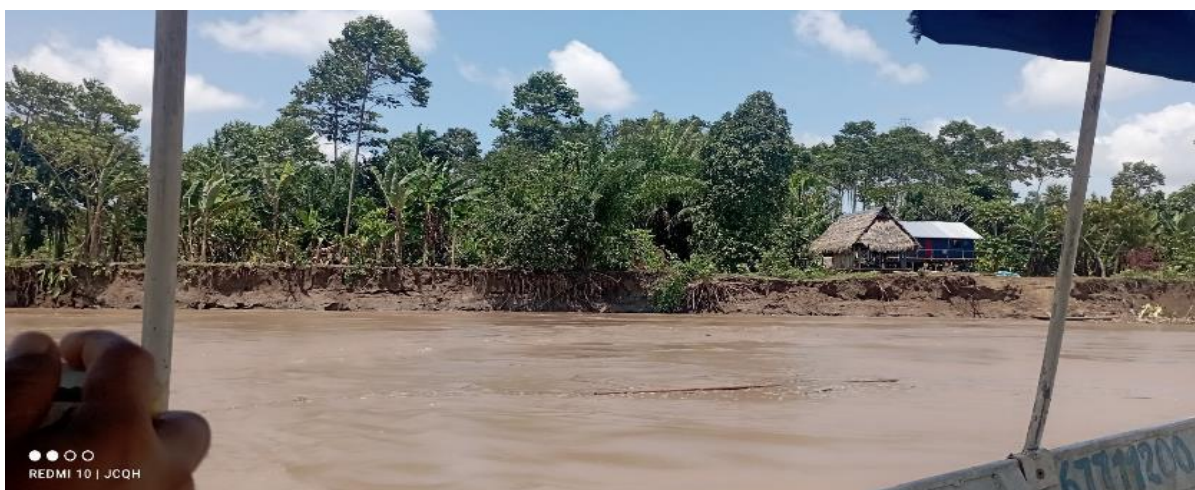
FIGURA N°02: VIVIENDAS EN RIESGO EN LA ORILLA DEL RIO UCAYALI QUE SE MUESTRA EROSIONADA
